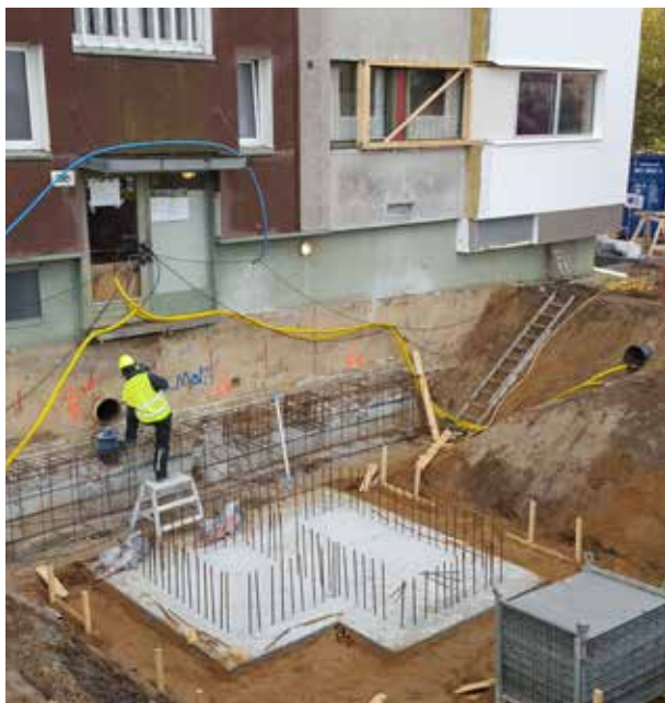
Fundamentet til det nye elevator-tårn i Rosenhøj 5C er ved at blive støbt.
